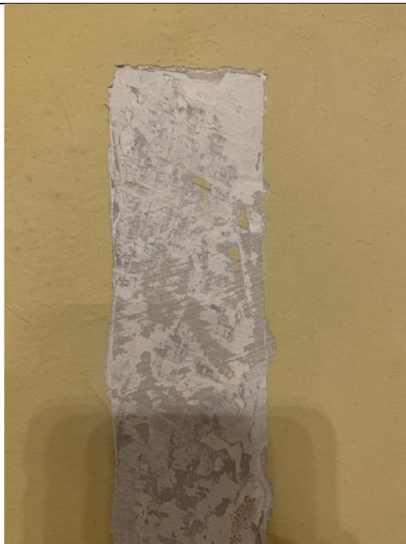
Odkrywka 6- Kościół p.w. Trójcy Przenajświętszej w Starych Juchach- tynk, widoczna szara warstwa.
