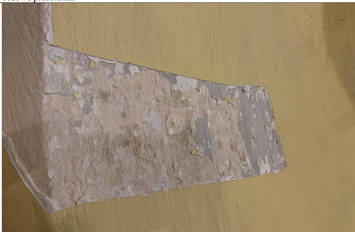
Odkrywka 10- Kościół p.w. Trójcy Przenajświętszej w Starych Juchach- tynk, widoczna szara warstwa.
