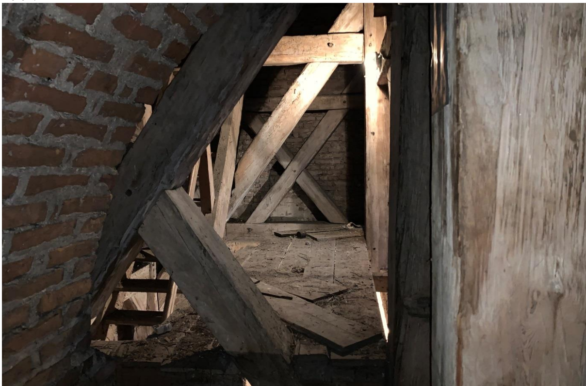
Fot.17. Stare Juchy- kościół znajdująca się przy ul. Elckiej 16 – więźba dachowa stan obecny. Fot. M.Feiertag-Baran.
