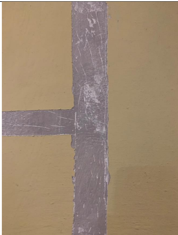
Odkrywka 5- Kościół p.w. Trójcy Przenajświętszej w Starych Juchach- tynk, widoczna szara warstwa.
