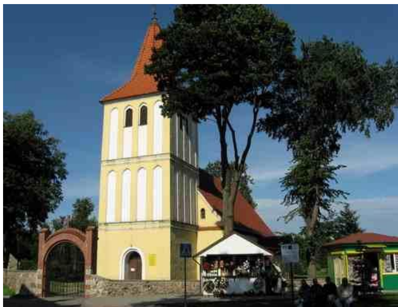
Fot.2. Kościół p.w. Trójcy Przenajświętszej w Starych Juchach- stan obecny 2012 rok 2
