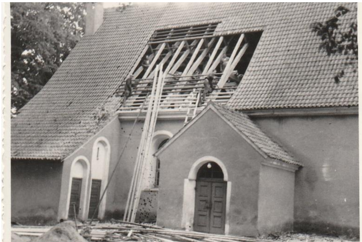
Fot.4. Kościół p.w. Trójcy Przenajświętszej w Starych Juchach- w trakcie naprawy dachu- autor nieznany.
