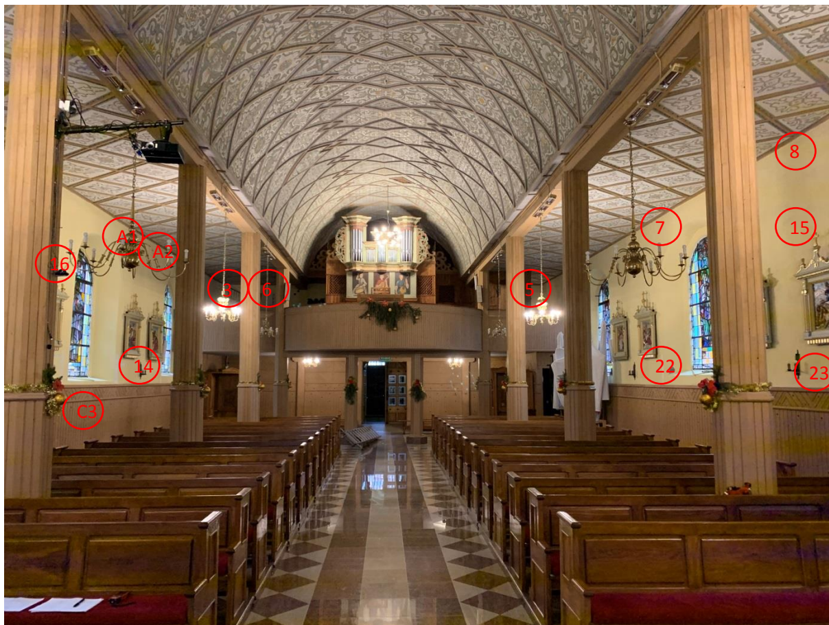
Fot.14. Stare Juchy- kościół przy ul. Elckiej 16 – tynki wewnętrzne- miejsca pobrania próbek. Fot. M. Feiertag-Baran.
