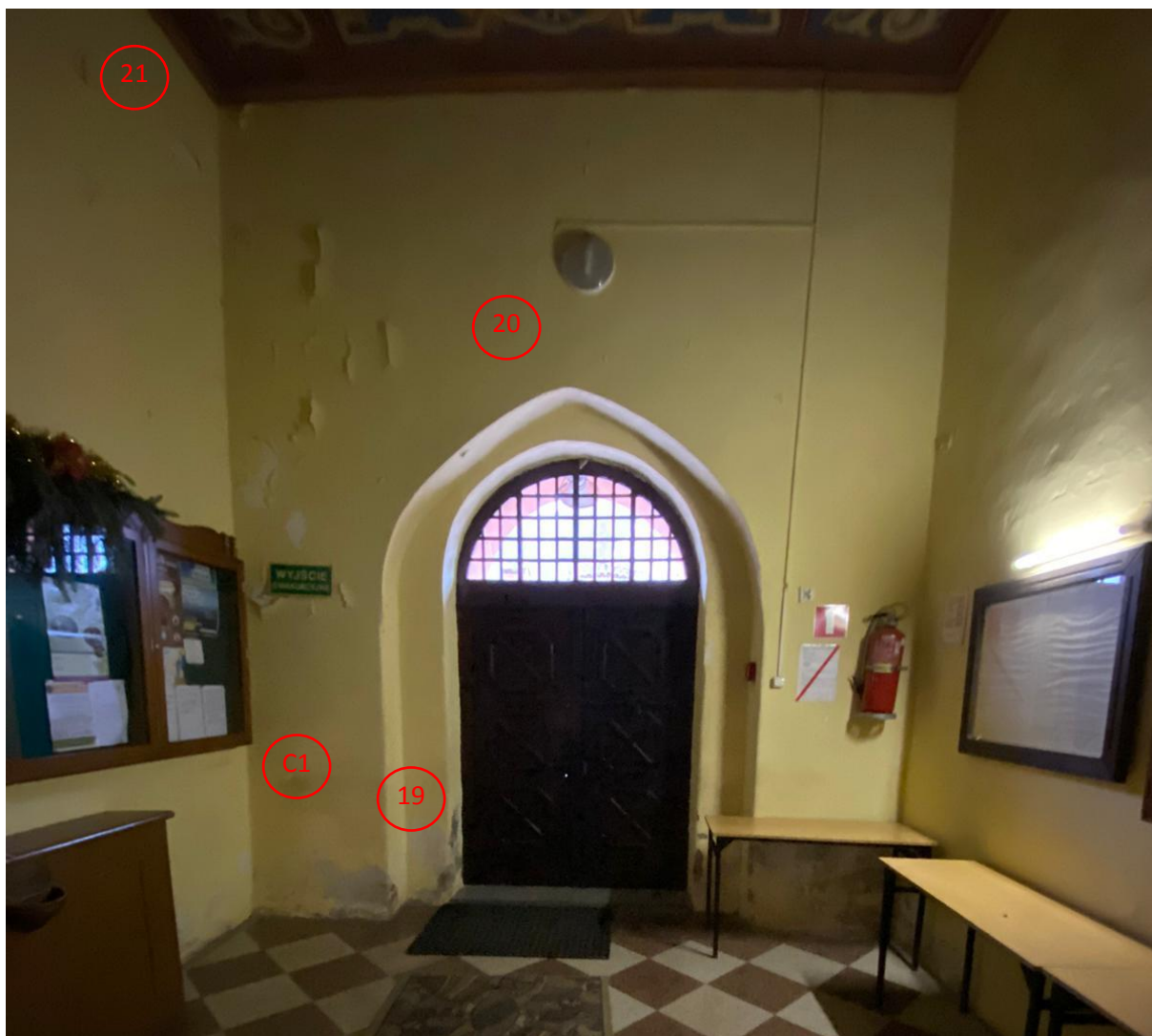
Fot.15. Stare Juchy- kościół przy ul. Elckiej 16 – tynki wewnętrzne- miejsca pobrania próbek. Fot. M. Feiertag-Baran.
