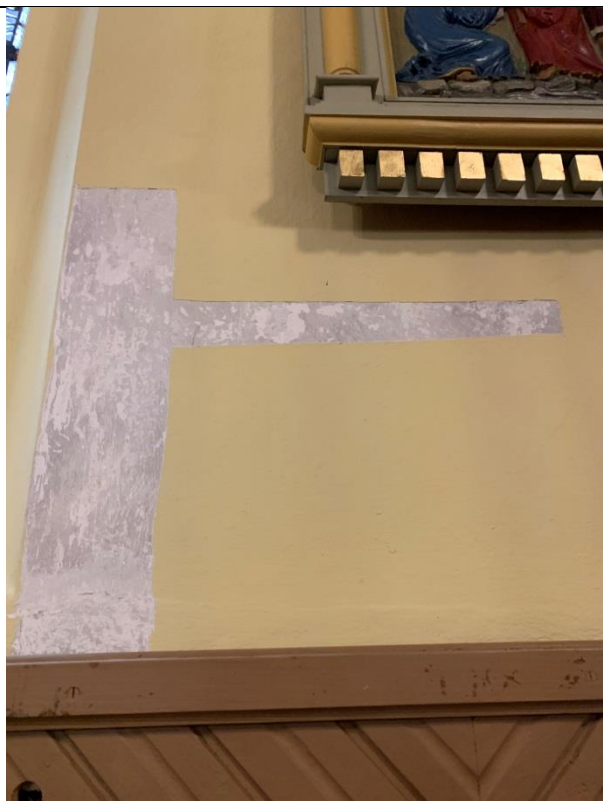
Odkrywka 7- Kościół p.w. Trójcy Przenajświętszej w Starych Juchach- tynk, widoczna szara warstwa.
