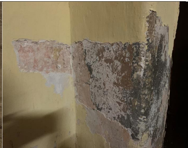
Odkrywka 12- Kościół p.w. Trójcy Przenajświętszej w Starych Juchach- tynk, widoczna szara warstwa.
