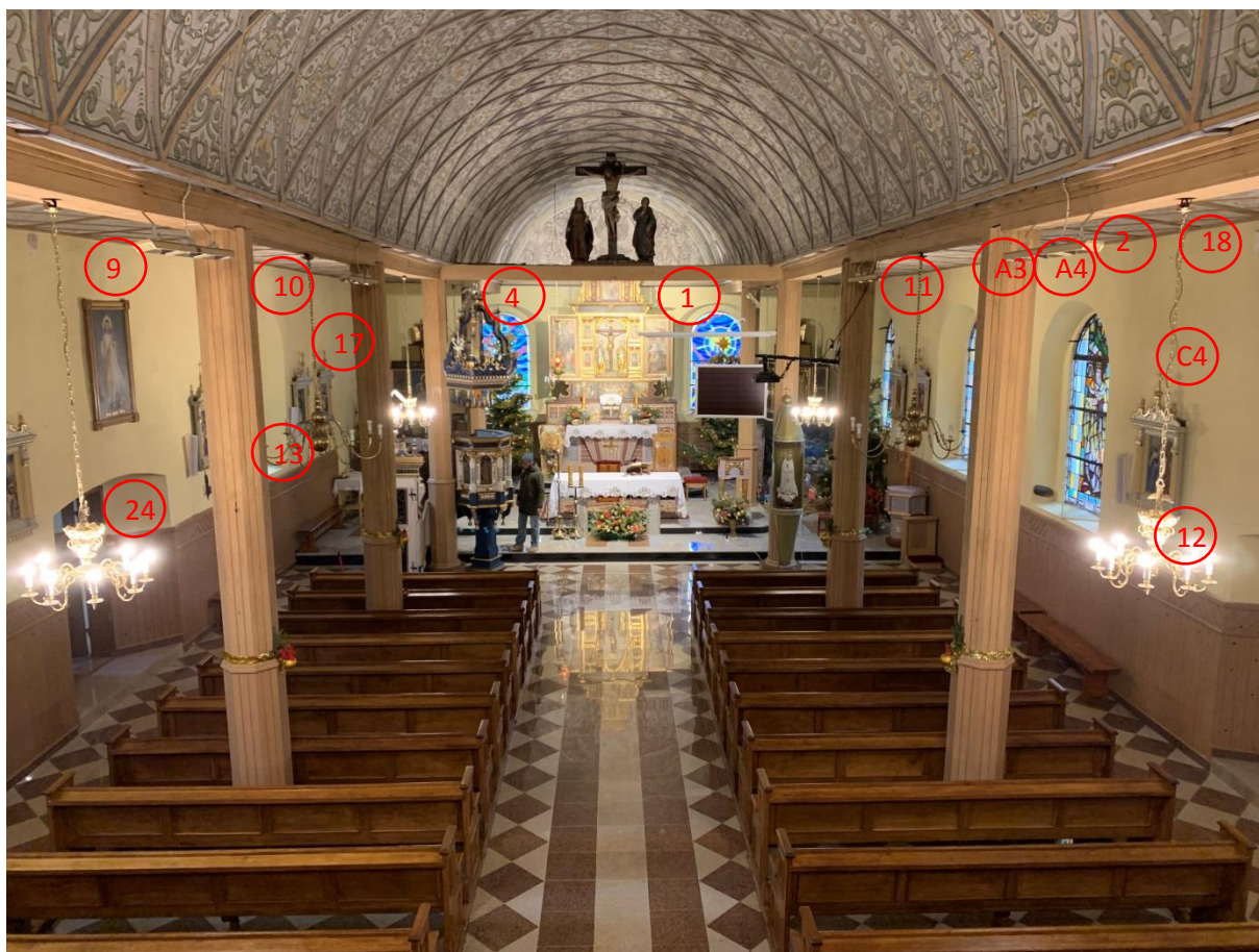
Fot.13. Stare Juchy- kościół przy ul. Elckiej 16 – tynki wewnętrzne- miejsca pobrania próbek. Fot. M. Feiertag-Baran.
