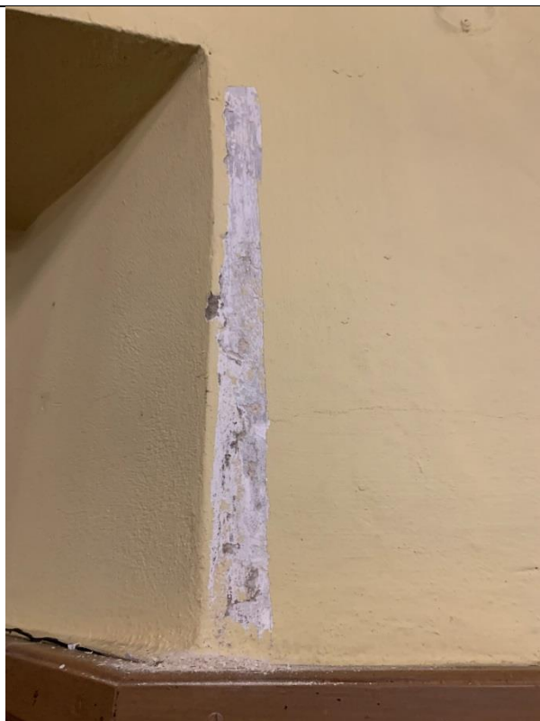
Odkrywka 8- Kościół p.w. Trójcy Przenajświętszej w Starych Juchach- tynk, widoczna szara warstwa.
