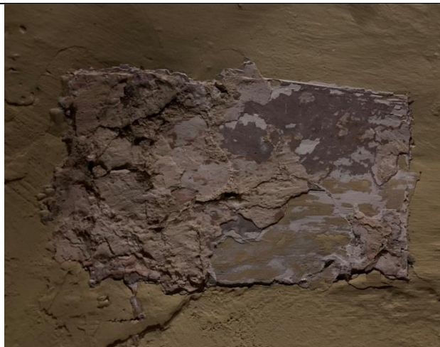
Odkrywka 11- Kościół p.w. Trójcy Przenajświętszej w Starych Juchach- tynk, widoczna szara warstwa.
