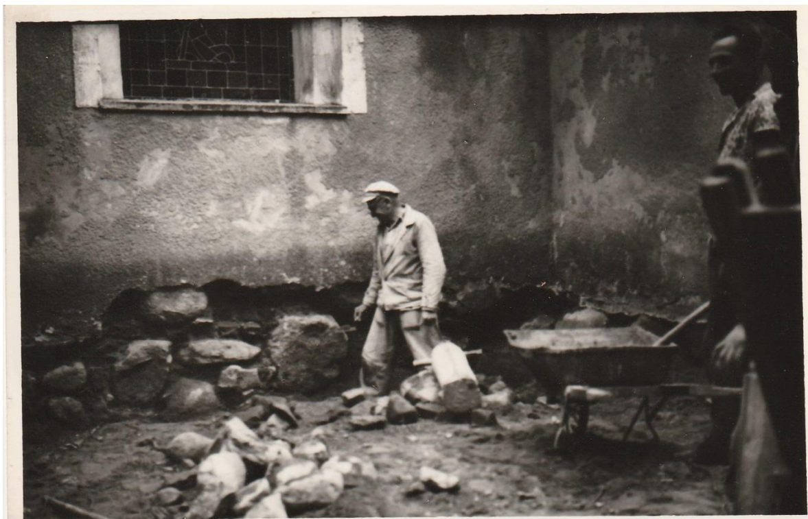
Fot.5. Kościół p.w. Trójcy Przenajświętszej w Starych Juchach- w trakcie naprawy fundamentów i cokołu- autor nieznany.
