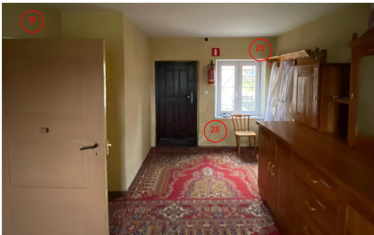
Fot.17. Stare Juchy- kościół przy ul. Elckiej 16 – tynki wewnętrzne- miejsca pobrania próbek. Fot. M. Feiertag-Baran.
