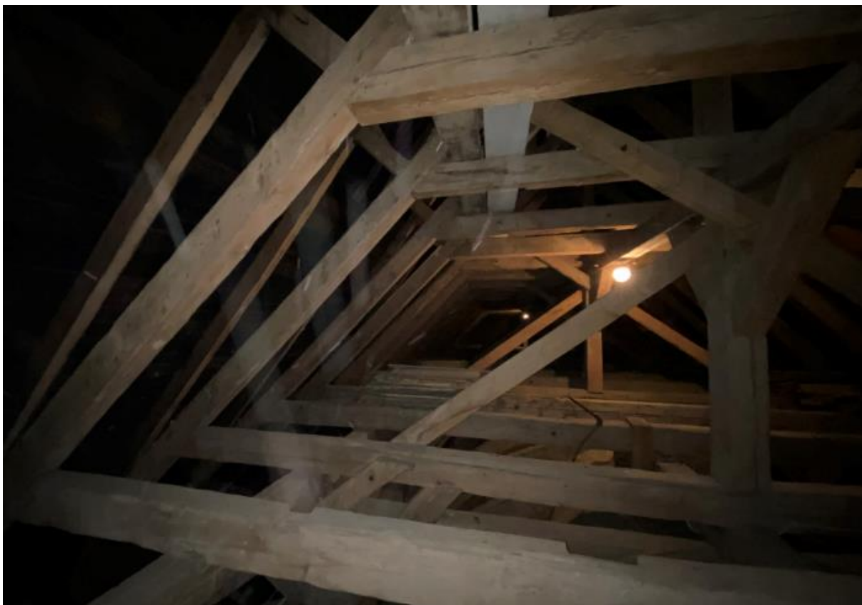
Fot.3. Stare Juchy, Kościół p.w. Trójcy Przenajświętszej, ul. Ełcka 16 – więźba dachowa. Fot. J.Baran.
