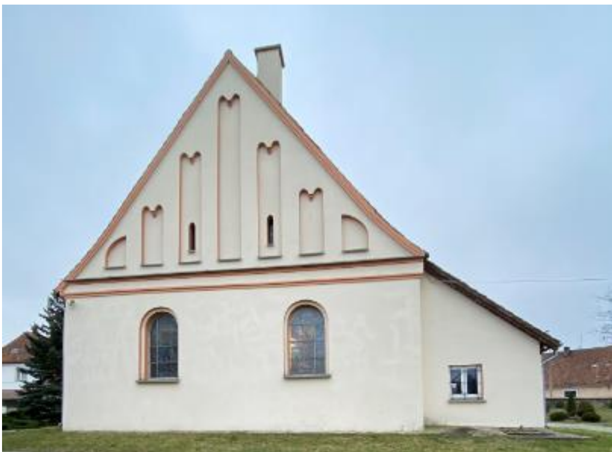
Fot.2. Stare Juchy, Kościół p.w. Trójcy Przenajświętszej, ul. Ełcka 16 – elewacja tylna, stan obecny. Fot. J.Baran.
